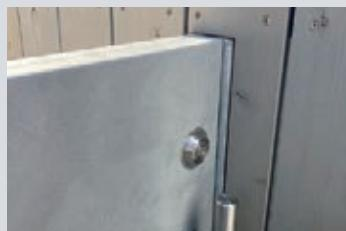
南浦和に新しく建てられた保育施設。施設の顔ともいえる、出入口のスライド式門扉に「塗る亜鉛テクスチャー」を意匠的に採用。水性ローバルを下塗りすることで屋外鉄部でも非常に高いさび止め効果を発揮します。
