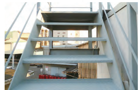
外部鉄骨階段
