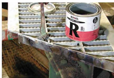
グレーチング 溶接部補修
